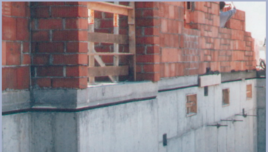
Bild 2: Ausgeschaltete fertige Lagerfuge
