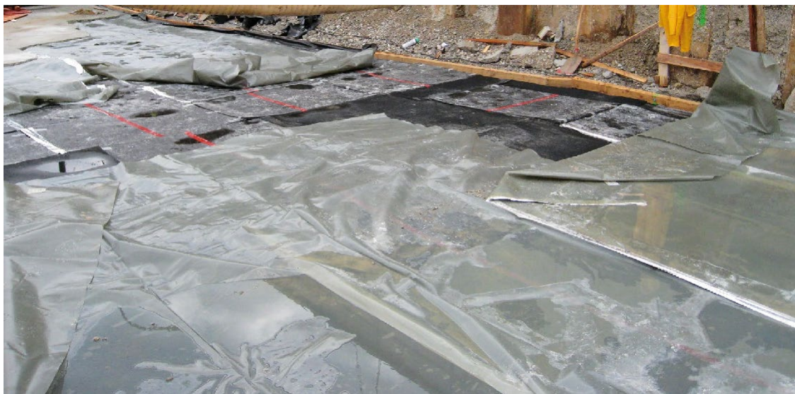
Obr. 15: Nainstalované prvky Cimax® částečně zakryté stavební fólií, ve výstavbě
