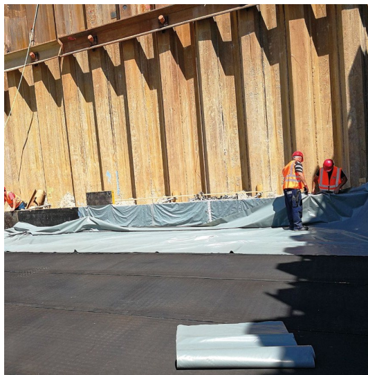
Obr. 9: Elastomerová nosná plocha potažená stavební fólií
