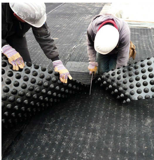
Obr. 8: Instalace a řezání Cibatur® na míru
