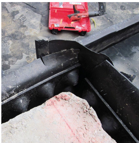
Obr. 11: Cibatur® připevněný vertikálně k základové stěně pomocí dřevěného hranolu
