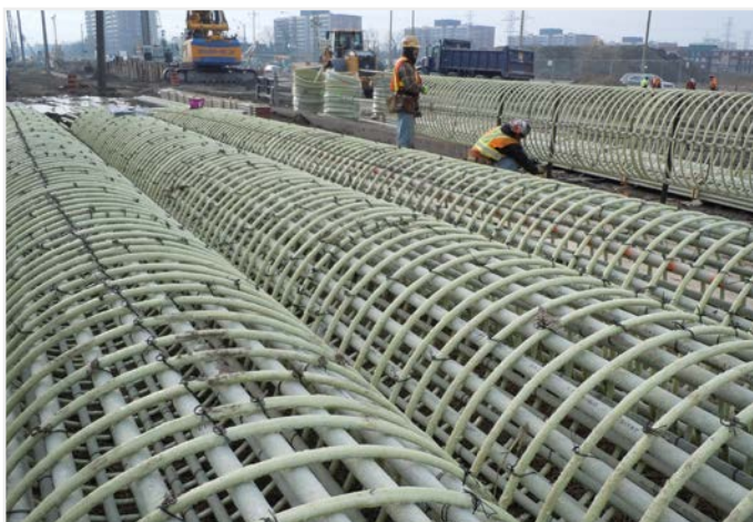
Výztužné koše z materiálu FIBERNOX® V-ROD s přímými tyčemi a spirálovými výztuhami
