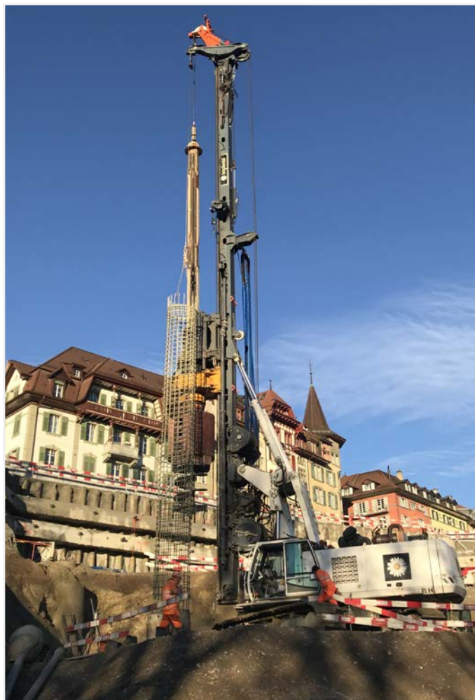
Bohrpfähle der Baugrube Wildpark Bahnhof Bern, Schweiz
