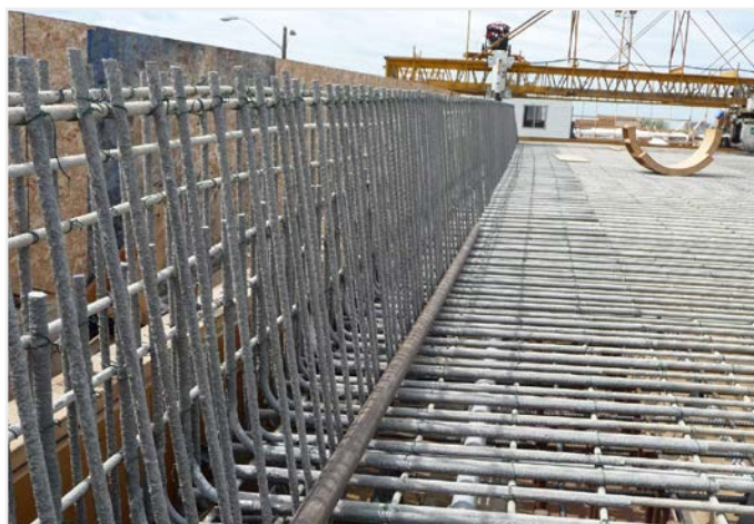
Montáž FIBERNOX® V-ROD v mostovkách a betonových svodidlech
