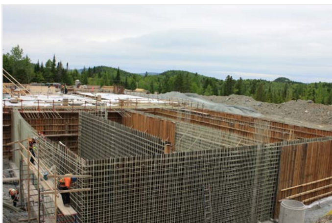
Nádrž čistírny odpadních vod, vyztužení stěn a podlahových desek
