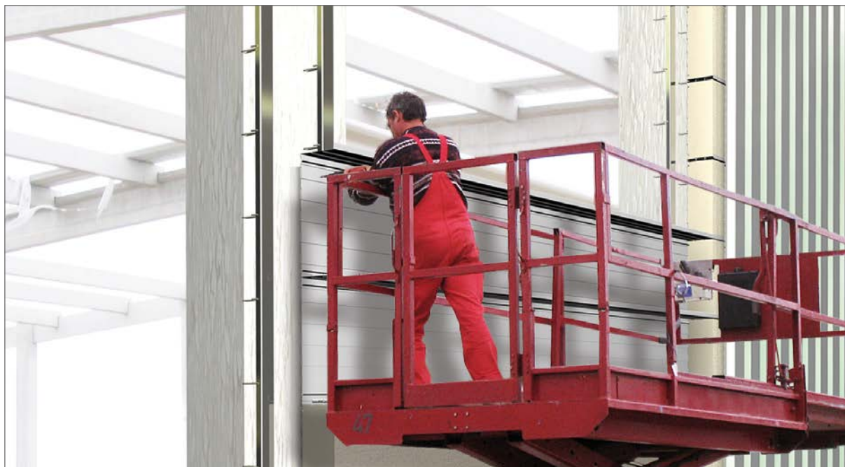
Montáž vícevrstvé zateplené stěny z trapézového plechu.
