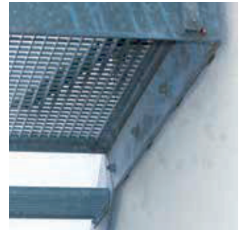
Treppenfestigung mit DB-Ankern
