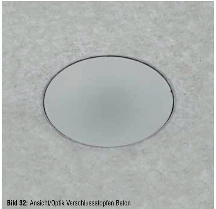
Bild 32: Ansicht/Optik Verschlussstopfen Beton
