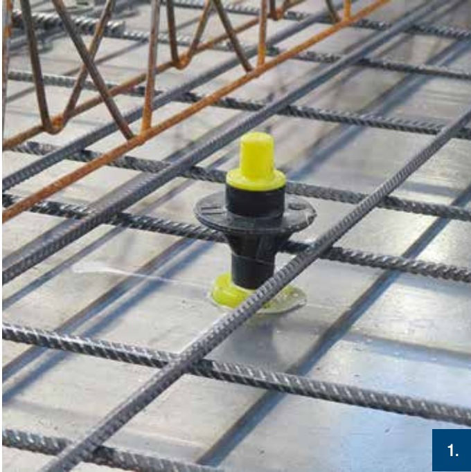
Bild 1: Aufgeklebter MoFi (Option 4)
