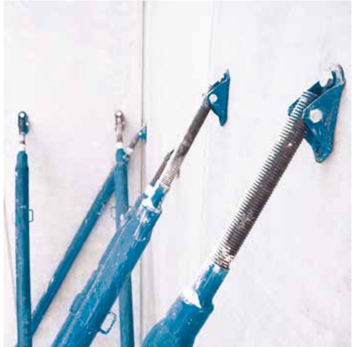
Bild 21: Schrägstützenkopf an MoFi angeschlossen
