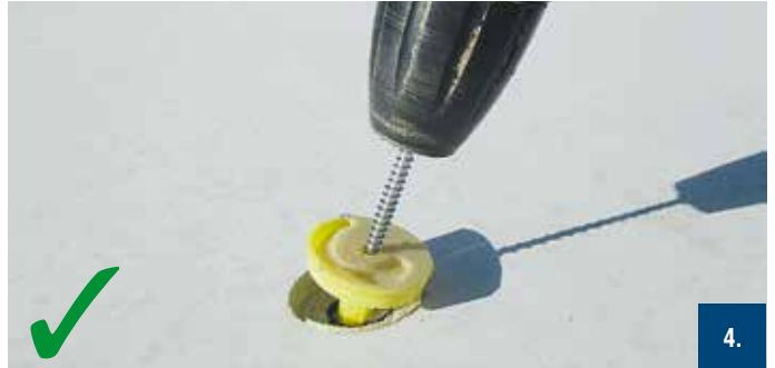
Bild 16: Herausziehen der Kunststoffaussparung
