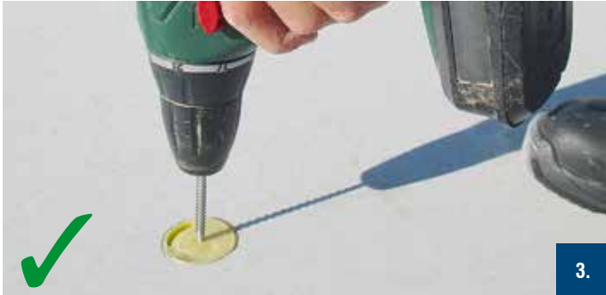
Bild 15: Anbohren mittels Akkuschauber (alternativ mittels Handwerkzeug)
