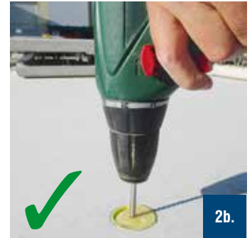
Bild 13 und 14: Detail – Anbohren der Kunststoffaussparung
