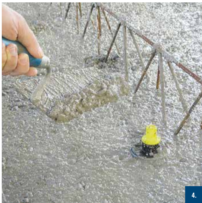
Bild 5: Bedecken der MoFi-Rückseite mit Beton
