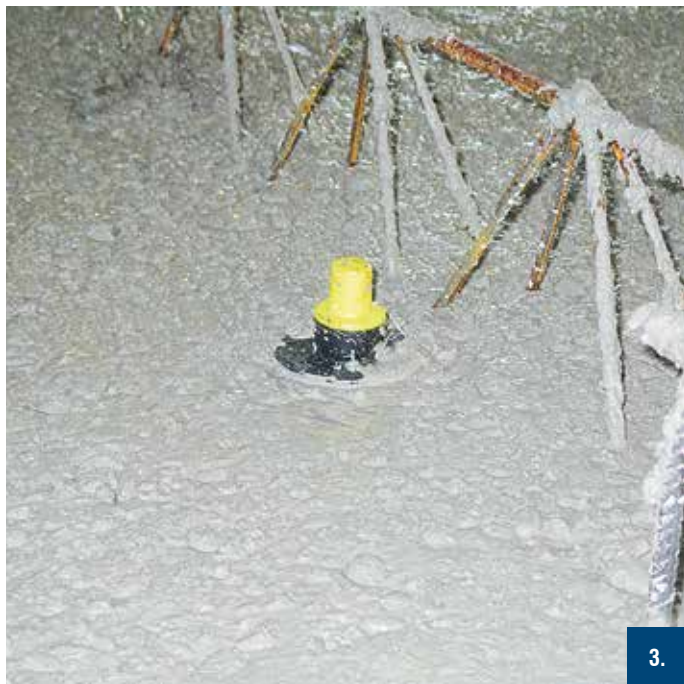
Bild 4: MoFi nach Verdichtung des Betons
