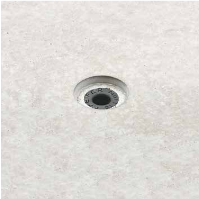
Bild 20: Eingebauter MoFi mit Innengewinde
