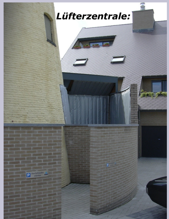
Stationäre Einhausung (an Wand mittels Dübel befestigt)
