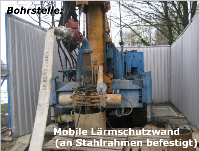
Mobile Lärmschutzwand (an Gerüst befestigt)
