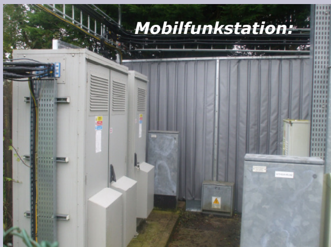
Stationäre Einhausung (an Stahlrahmen befestigt)
