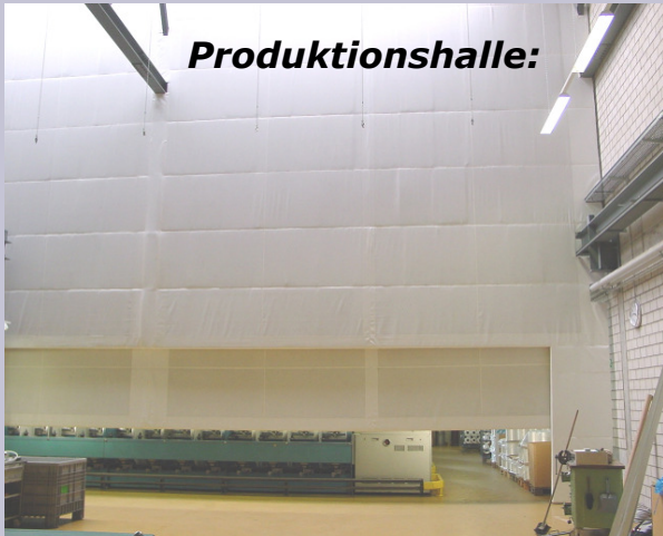
stationäres Vorhangsystem (an Stahlrahmen befestigt)
