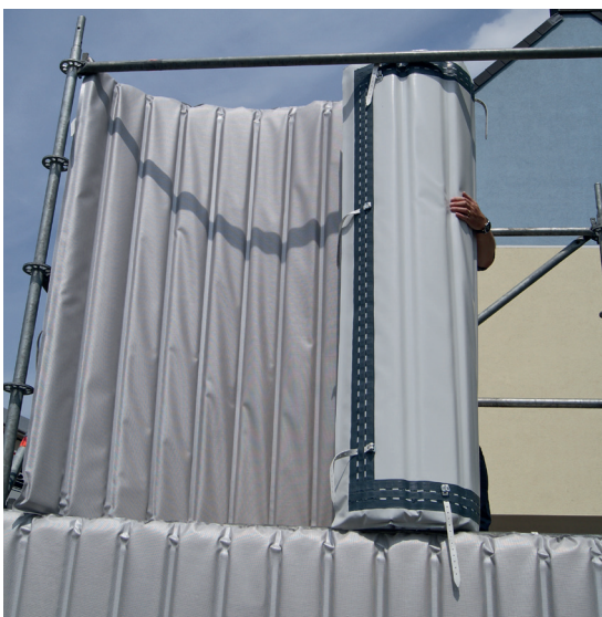
Ausrollen im Gerüstfeld
