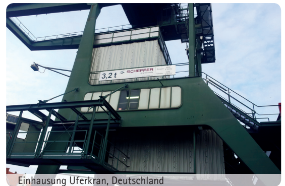
Einhausung Uferkran, Deutschland
