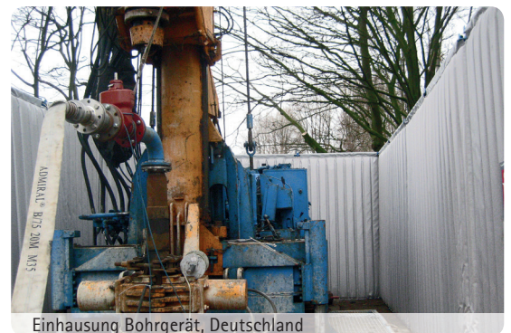
Einhausung Bohrgerät, Deutschland
