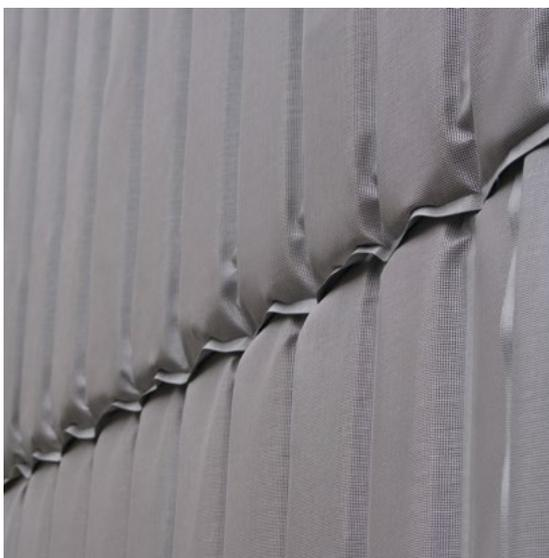
Bild 8: Befestigung Schleppstreifen an Gerüststange
