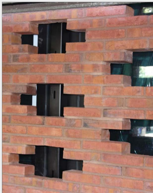
JORDAHL® Windposts für die Übertragung von horizontalen Lasten zwischen zwei Geschossen
