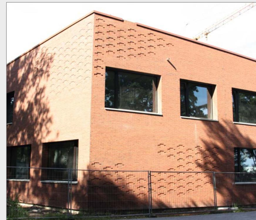
Anspruchsvolles Verblendmauerwerk ohne Luftschichtanker
