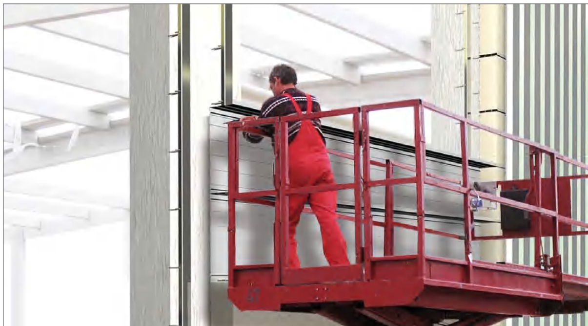
Montáž vícevrstvé zateplené stěny z trapézového plechu.
