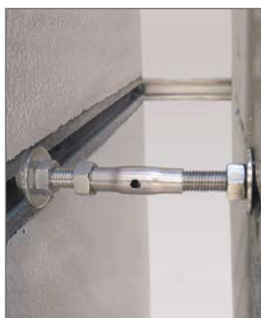
Spojovací prvky s rektifikací JSV k trojrozměrnému vyrovnání.
