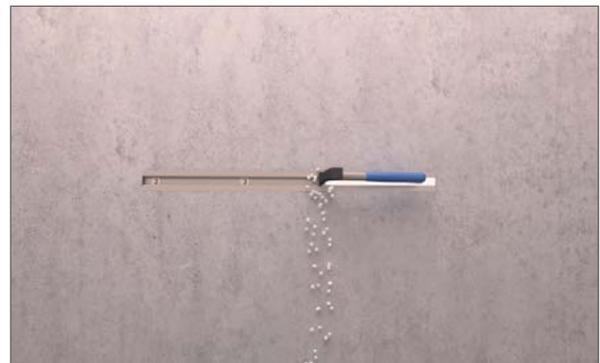
Schaumfüllung der Ankerschienen mit Hilfe eines geeigneten Werkzeuges entfernen
