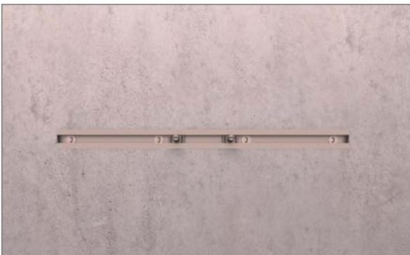
JORDAHL® Schrauben waagrecht in den Schienenschlitz einsetzen und um 90° drehen
