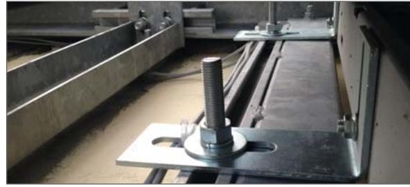
Befestigung von Aufzugstüren in einem Gitterträgerschacht
