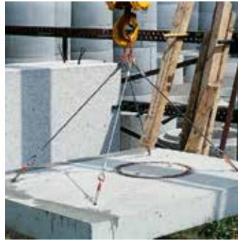
Anschlagseile im Vierstrang-Einsatz – Nur drei Stränge tragend
