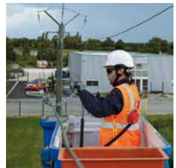
Sicherung in Arbeits- und Hebebühnen
