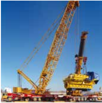
Kombination aus mehreren Anschlagmitteln für das sichere Handling sehr großer Lasten
